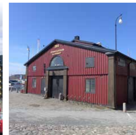
Kajskjul 8 (Nordstaden 702:32) Uppförd: 1885 Skydd: Rivningsförbud och skydds- föreskrifter i detaljplan
