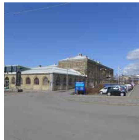
Tull och Packhuset
