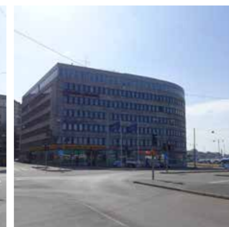
Skeppsbrohuset Uppförd: 1935 och 1967 Skydd: Ingår i bevarandeprogrammet
