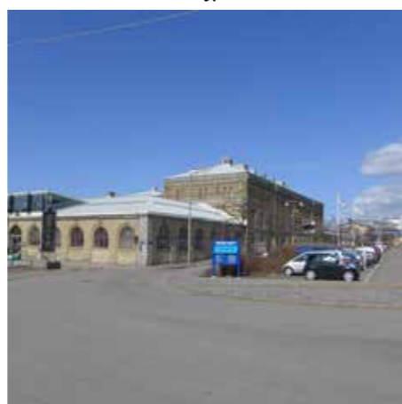
F d Tull- och Packhuset Uppförd: 1864 Skydd: Rivningsförbud och skydds- föreskrifter i detaljplan
